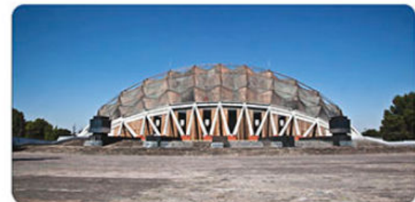
Fig. 2.36 El Palacio de los Deportes en la Ciudad de México es una estructura que fue construida para los Juegos Olímpicos de 1968. Su fachada exterior consta de una cúpula de cobre formada por cuadros que cubren un área aproximada de 67 000 m 2 .
